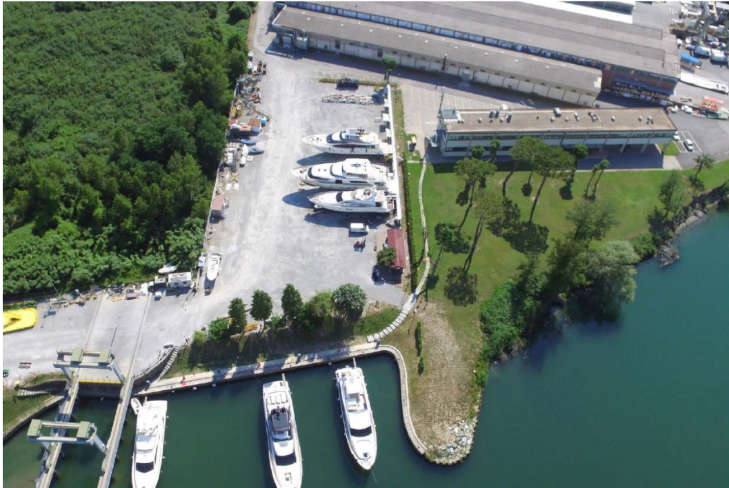
Area a Sud della palazzina uffici
